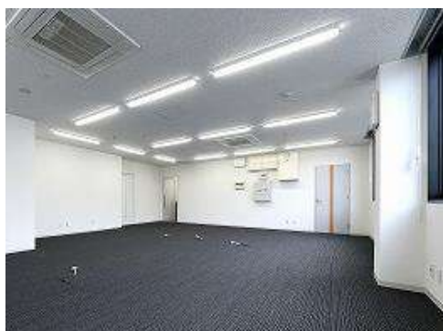
◇照明器具LED化工事
